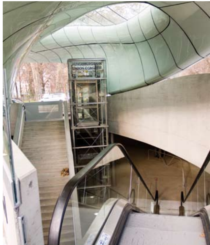
Der Eingang zur Talstation Congress Innsbruck: moderne Architektur entworfen von der Stararchitektin Zaha Hadid.
